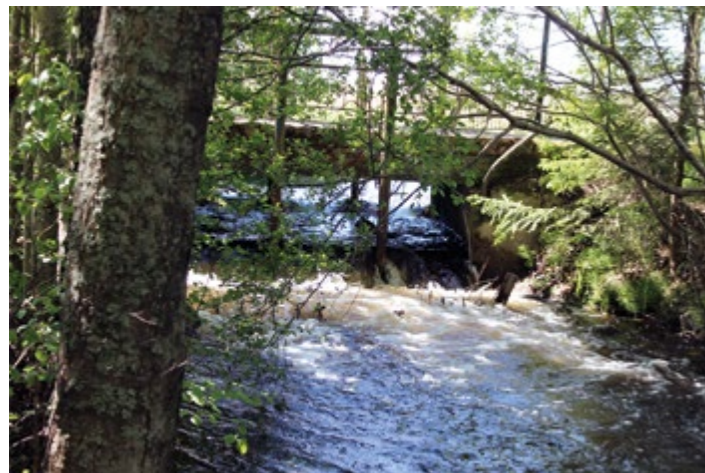
Плотина, комбинированная с мостовым переходом, в истоке р. Глубокой, 4 июня 2021 г. Фото И. Калюжного
